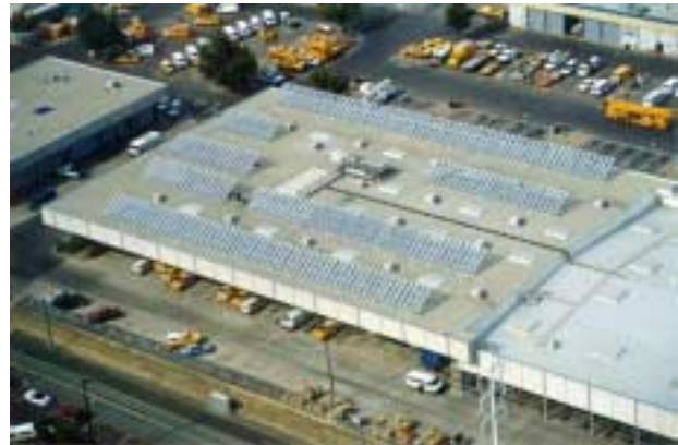
Fig. 1. 30.5 kW AC PVI Array at SMUD
