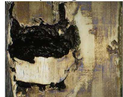
Spalling
