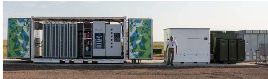
1-MW/1-MWh BESS at NREL test site
