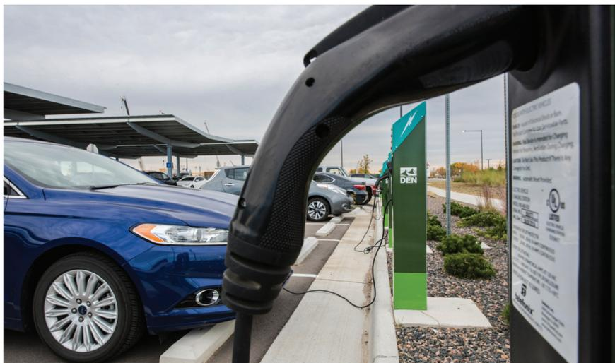
Les stations de recharge publiques comprennent généralement une ou plusieurs bornes de niveau 2 et peuvent également inclure des bornes de charge rapide DC.
